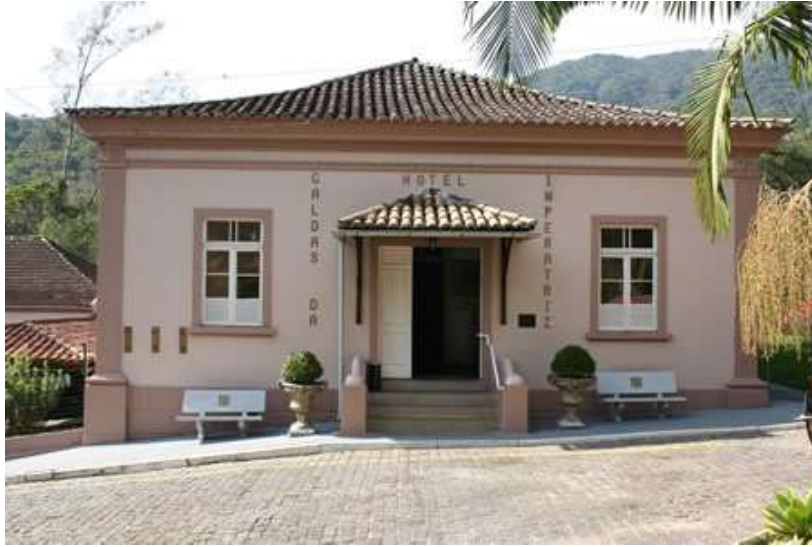
Figura 2 - Hotel de Caldas da Imperatriz onde se localiza a fonte.
